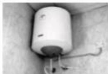
عند استعمال خدجة سخان الماء الكهربائي لاحظت ضعف تدفق الماء من الأنابيب مع انقطاع التيار الكهربائي عند تشغيل المدفأة الكهربائية. طرحت المشكلة على أبيها، فأخبرها أن ضعف التدفق نتيجة انسداد الأنابيب النحاسية بترسب مادة الكلس ( $\text{CaCO}_3$ ) فيها مقترباً تسرّحها باستعمال حمض كلور الماء، و لحل مشكل انقطاع التيار الكهربائي استعان الأب بالكهربائي ليطلعه على مخطط دارة الكهربائية الآتي:
