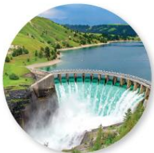
الشكل (9) بناء السدود
