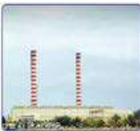
محطة تحلية مياه البحر
