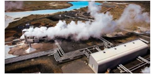
الشكل 6 تحوّل محطات توليد الطاقة الحرارية الأرضية الطاقة الحرارية للجسيمات الموجودة عميقًا في باطن الأرض إلى طاقة كهربائية. والولايات التي تحتوي على أكبر عدد من محطات توليد الطاقة الحرارية الأرضية، هي آلاسكا وهاواي وكاليفورنيا.
