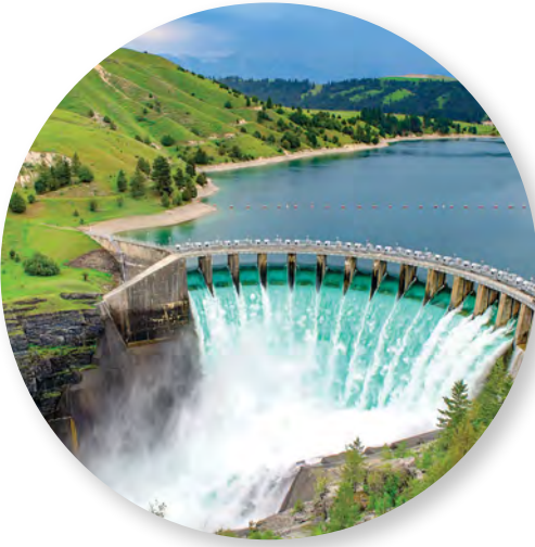
الشكل (9) بناء السدود
