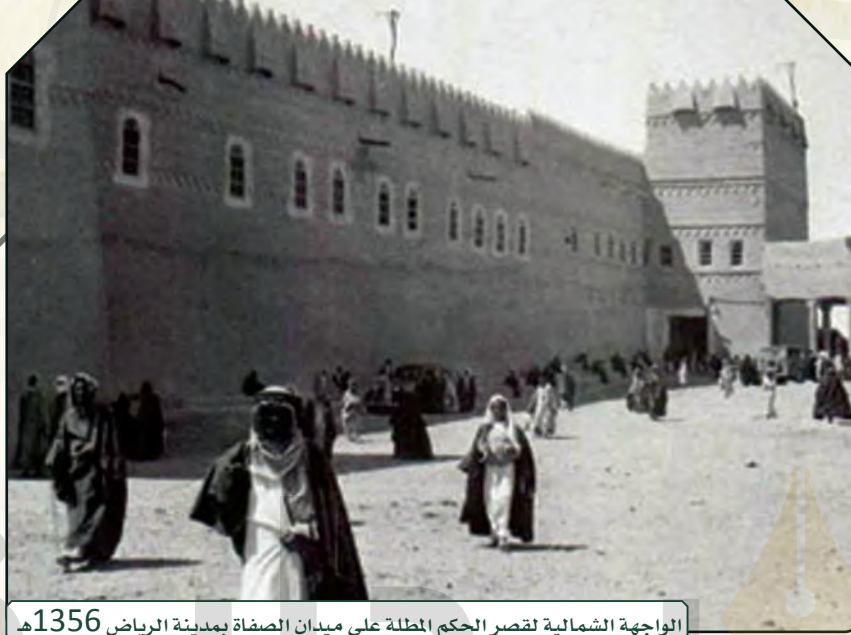
الواجهة الشمالية لقصر الحكم المطل على ميدان الصفاة بمدينة الرياض 1356هـ
