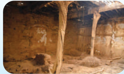
مسجد تاريخي قبل ترميمه
