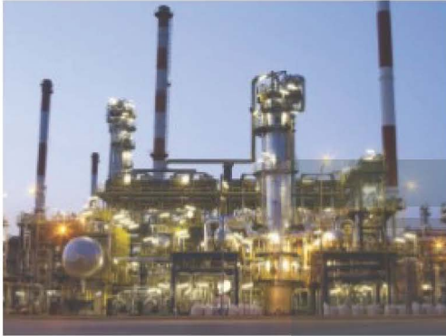
محطة توليد الكهرباء في الجبيل
