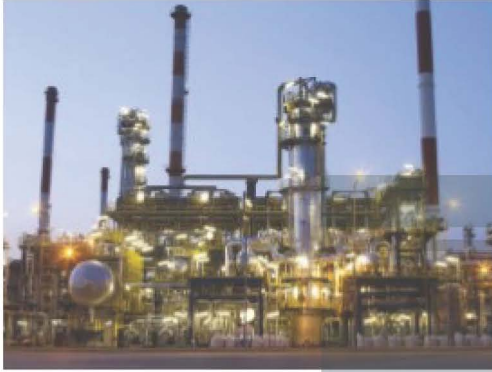
محطة توليد الكهرباء في الجبيل
