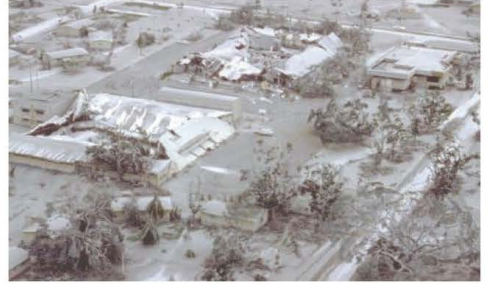
(أ) يؤدي الرماد البركاني الذي يغطي المنطقة إلى تدمير المنشآت، وقد يشكل تدفقاً طينياً إذا امتزج بالأمطار.
