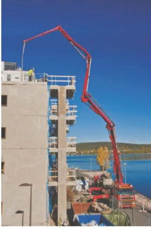
الشكل ٢٠ تستعمل بعض المعدات الهيدروليكية في أعمال البناء.
