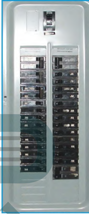
تعمل القواطع على حماية الدوائر الكهربائية من التيارات الكبيرة.
