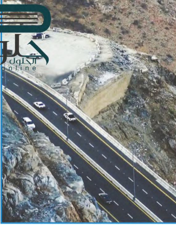
هذا الطريق سطح مائل
