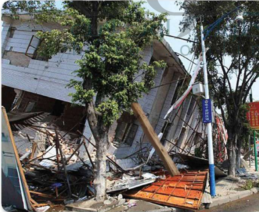
الشكل 16-7 المباني الخرسانية (الأسمتية) هشة غالباً، ويمكن أن تلتف بسهولة إذا وقع زلزال؛ فالمبنى الظاهر في الصورة أزيح من فوق أساسه عندما حدث الزلزال، وتم إنساده بعمود من الخشب.
