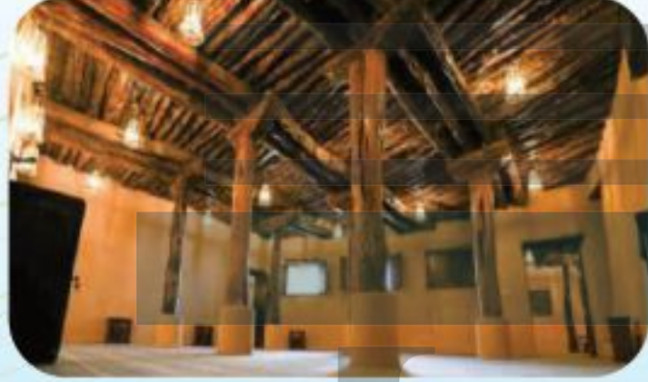
مسجد تاريخي بعد ترميمه
