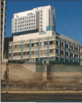
▲ مبنى منظمة أوبك في فيينا
