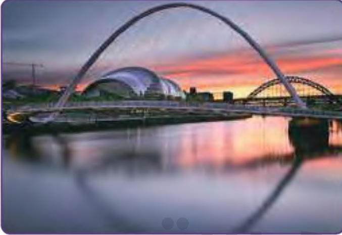
جسر المشاة (إنفينيتي) شمال إنجلترا
