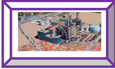
مشروع معالجة النفايات الصلبة
