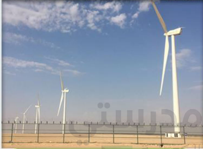
محطة الشقاييا لطاقة الرياح
