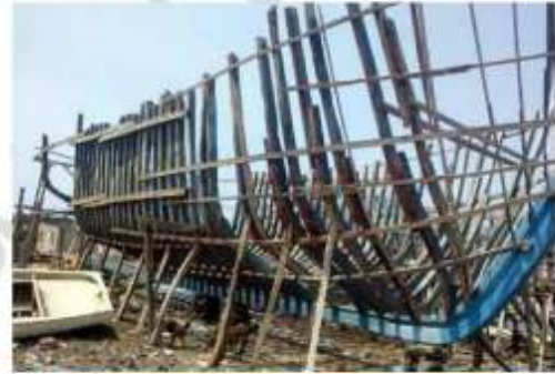
1- إنشاء الهيكل الخارجي للسفينة
