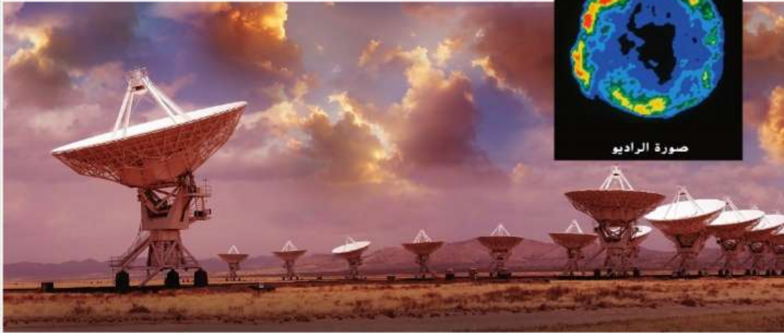
الشكل 4 غالبًا ما يتم إقامة التلسكوبات الراديوية في صفوف ضخمة. تحوّل أجهزة الحاسب بيانات الراديو إلى صور. تعمل الأدوات السبع والعشرون في هذه المصفوفة كتلسكوب واحد قطره 36 km.
