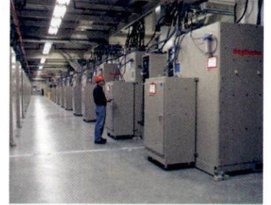
الشكل 4.21 ثمانية وأربعون وحدة لتكييف القدرة في إحدى الحجرات الأربع في منشأة الإشعاع الوطنية في مختبر لورانس ليفرمور الوطني.
