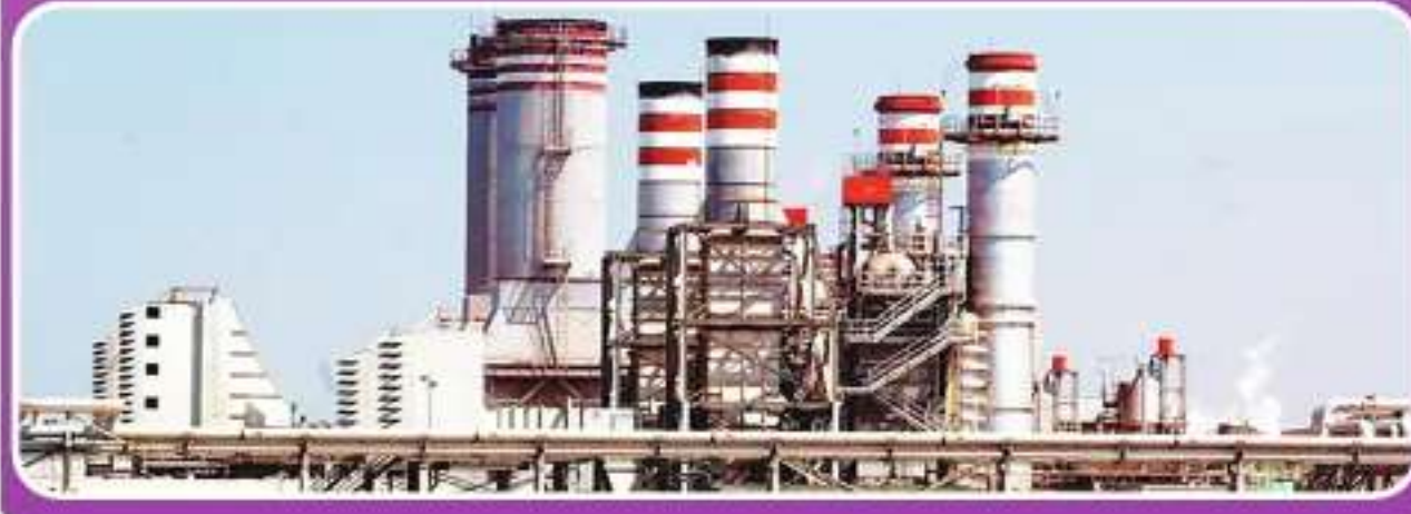
محطة تحلية المياه
